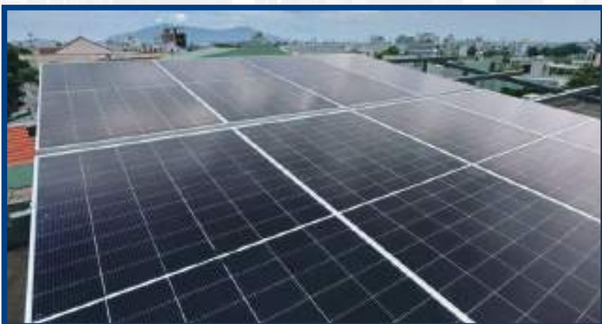
Dự án nhà anh Tiến
